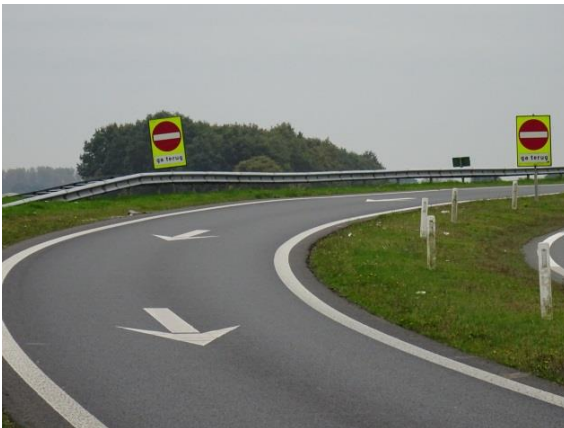
Autosnelwegafrit met borden en pijlen
