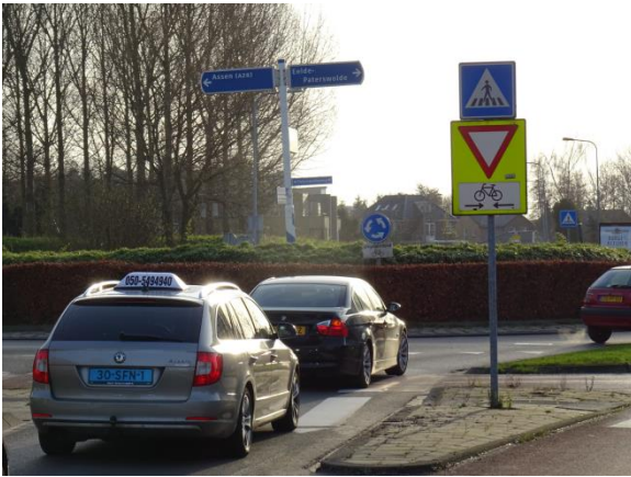
Rotonde met tweerichtingsfietspad, fietsers in de voorrang
