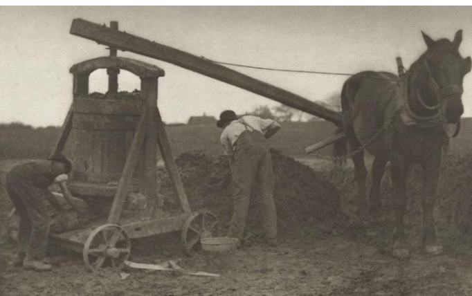
Afbeelding 15. Kleimolen aangedreven door een paard in Norfolk (Groot-Brittannië) omstreeks 1883-1888, fotograaf Peter Henry Emerson (Bron: www.rijksmuseum.nl ).
