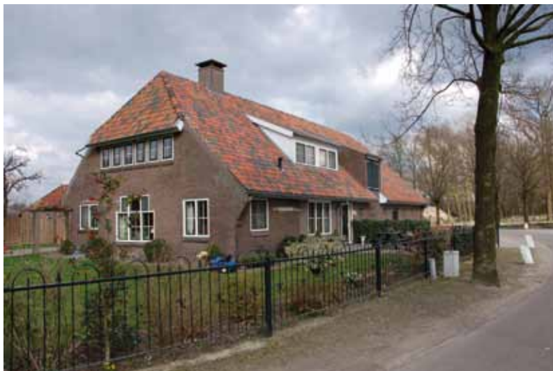
Afb. 6.19: wederopbouwboerderij Het Eerste Broek. De oorspronkelijke boerderij moest in de meidagen van 1940 worden afgebroken omdat deze in het schootsveld stond (foto N. Welle, 2015).
