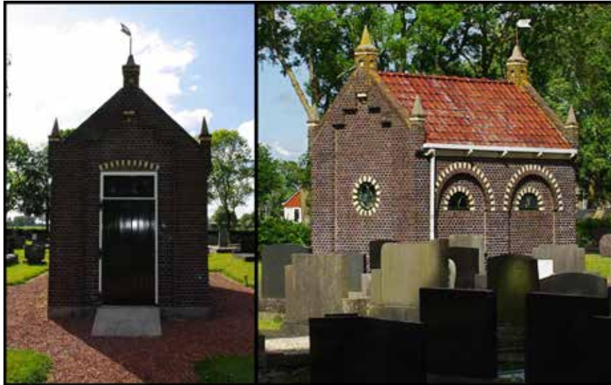
Afb. het lijkhuisje uit 1924, een rijk gedecoreerd gebouwtje. Foto: auteur 2010
