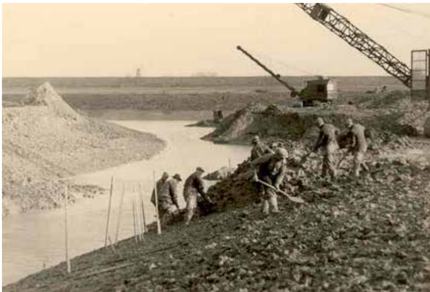
Afb. 52 Na het verbod op het gebruik van gasolie stonden de draglines stil en moest men met de hand verder werken. Dit was een loodzware klus in de zware klei en zorgde voor een enorme kostenstijging tijdens de oorlogsjaren. Bron: foto uit privearchief J.Hofman (voormalig hoofd van de begraafplaats Selwerderhof)
