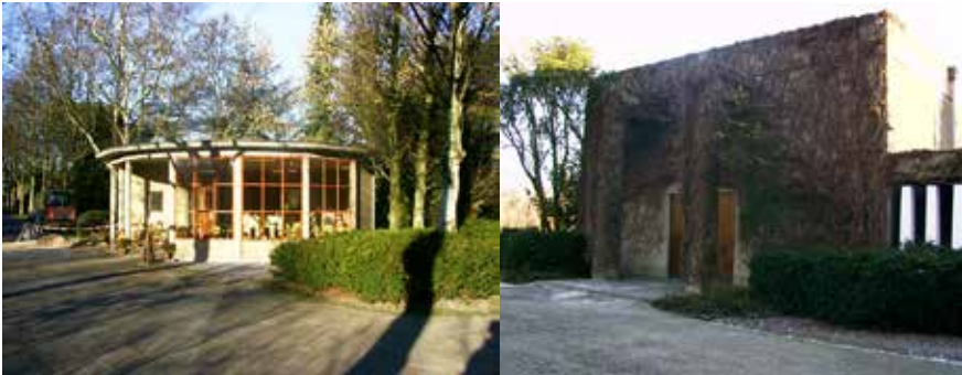
Afb. 60 Links de eerste aula (thans theehuis) en rechts de tweede aula vlak voor renovatie. Foto's: auteur.
