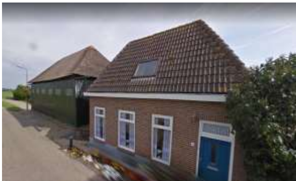
Figuur 2.19: Het boerenhuis van Albert Tuin, gebouwd tegen de zeedijk van de polder Mastenbroek, bij het gehucht Cellemuiden. Links de hooischuur van Albert Tuin uit 1947.
