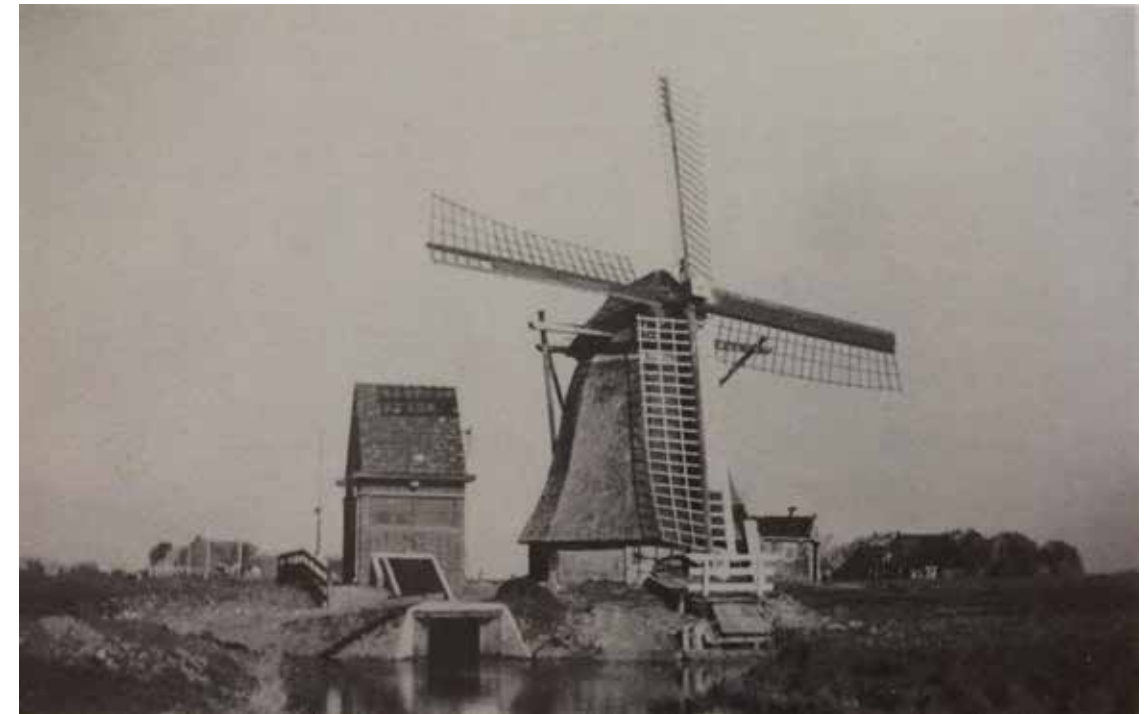
Afb. 2.10: De poldermolen van Leons met daarnaast het gemaal in aanbouw. Foto rond 1935/1936. Bron: Archief Littenseradiel /Wommels. Niet gearchiveerd.
