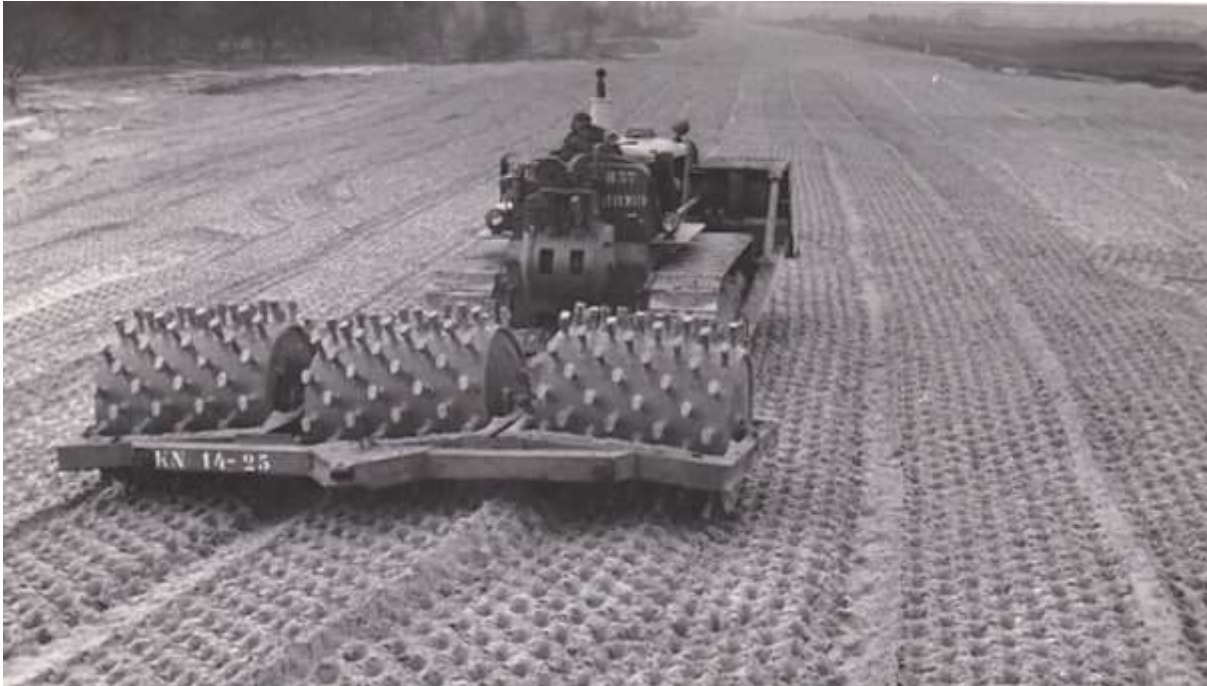
Afbeelding 2.11 Het verdichten van een rondweg/tankbaan op het OT Leusderheide door een wals met 'bokkenpoten', nadat het terrein eerst is diepgeploegd en geëgaliseerd. Deze werkzaamheden zijn midden jaren zestig van de vorige eeuw uitgevoerd na de intensivering van het militaire gebruik als gevolg van de mechanisering van het Nederlandse leger. Archief RVB/Defensie te Utrecht.
