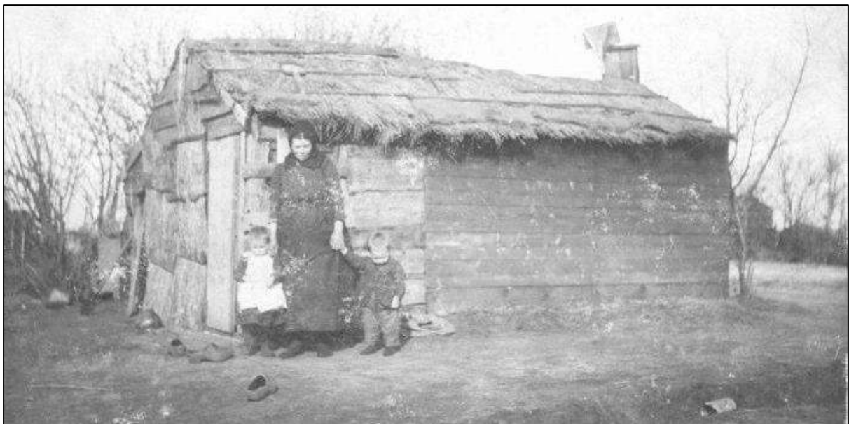
Afb. 41. Een voorbeeld van een woning van een turf arbeider in 1906. Deze onbewoonbaar verklaarde woning aan de Prikkewei was opgebouwd van hout en plaggen (bron: Fries Fotoarchief Tresoar, nr. 15353).
