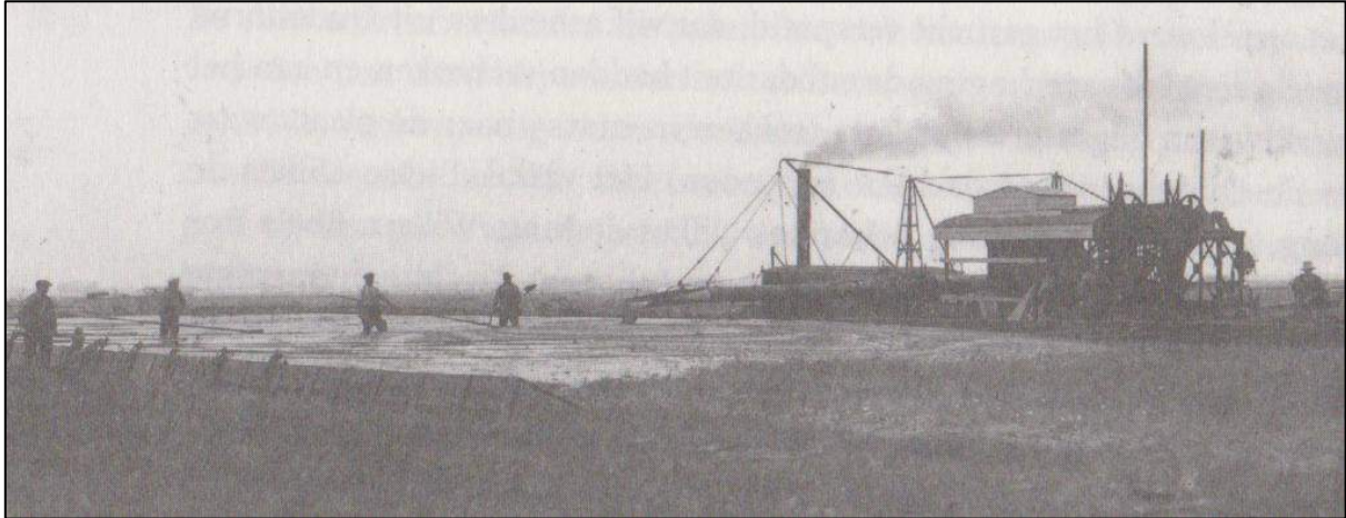
Afb. 34. Natte verving die werd uitgevoerd met een baggermachine. Deze machine smeeet in een korte tijd grote hoeveelheden veen op de wal, waardoor geen handwerk meer nodig was. Een van de gevolgen was dat toenmalige veenarbeiders werkloos raakten (bron: it Damshûs).
