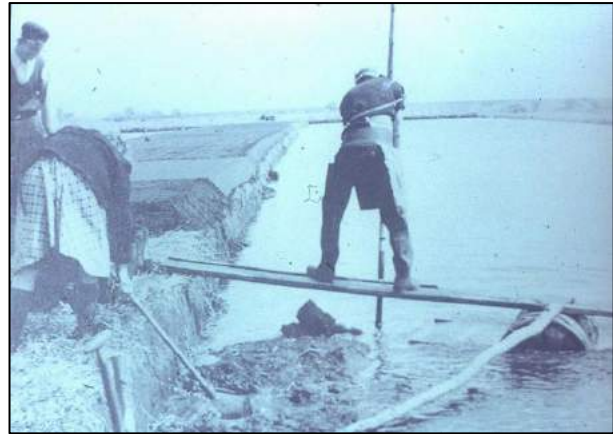
Afb. 13. Vervenen op de Gieterse methode. Hierbij werd het veen met behulp van een baggerbeugel uitgegraven, waardoor geen smalle sloten en hagen achterbleven, maar grote watervlakten. De veenmodder werd met platbodems (bokken) naar droogpercelen gebracht (bron: Fries Fotoarchief Tresoar, nr. 24276)
