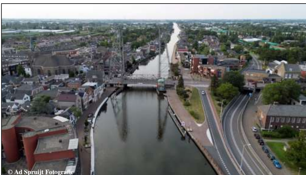
Figuur 3.7: Foto gemaakt van het zich op de stalen hefbrug over de Gouwe in Boskoop (Ad Spruijt, 2022).
