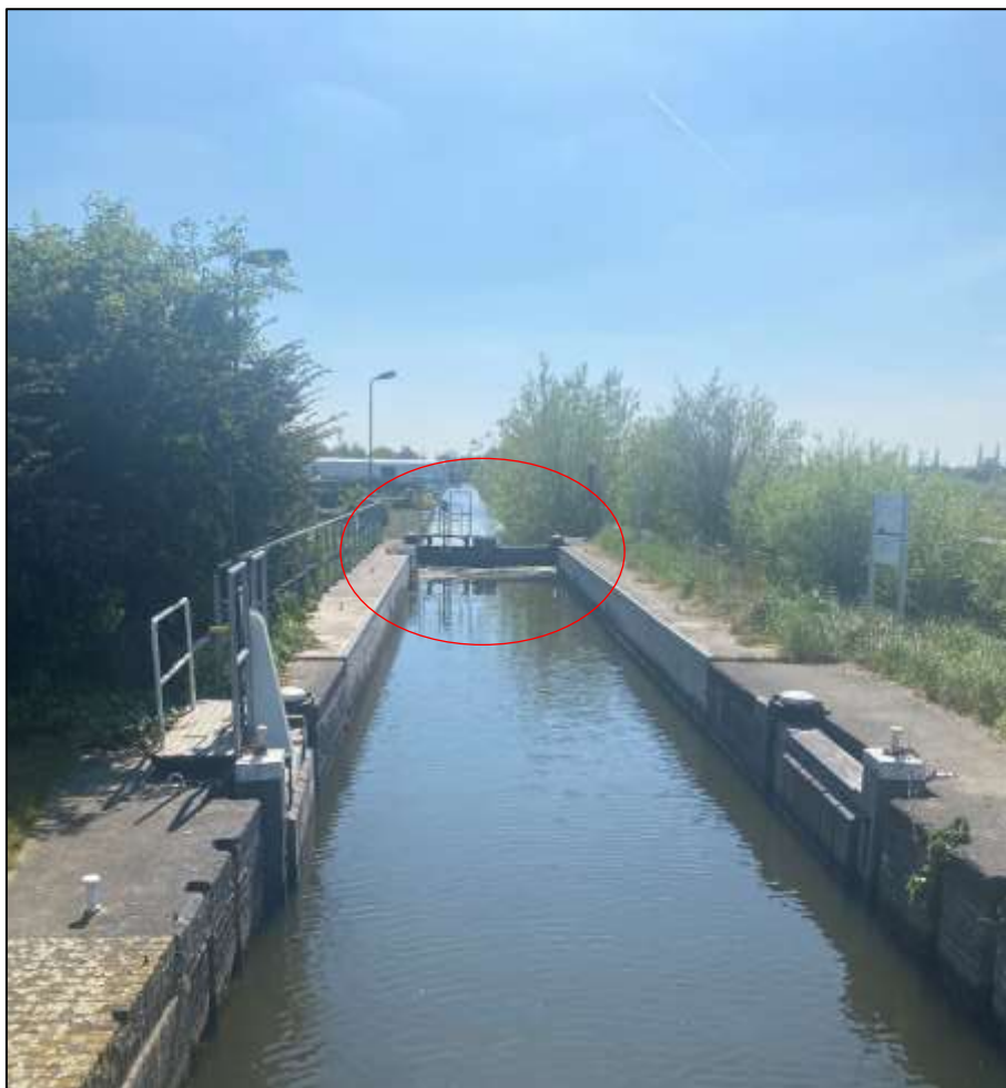
Figuur 2.13: Foto genomen van de sluis tussen de Otwegwetering en sloot van de Boskoopse Polder (R.Woning, 2022).
